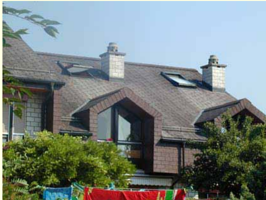
Tuiles en fibrociment
