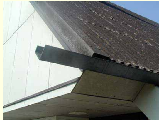
Wellplatten aus Asbestzement
