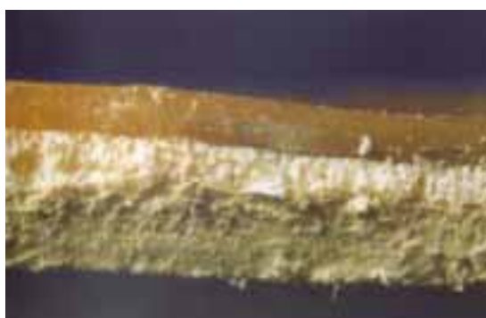
Sezione di un rivestimento usato per i pavimenti dei treni: lo strato inferiore è in cartone di amianto
