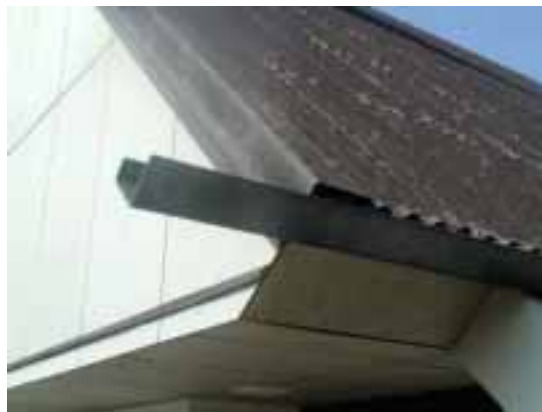
Lastre ondulate in cemento amianto
