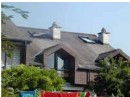
Ardesia per tetti in cemento amianto
