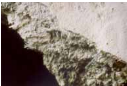
Sezione di lastra termoisolante in cemento amianto
